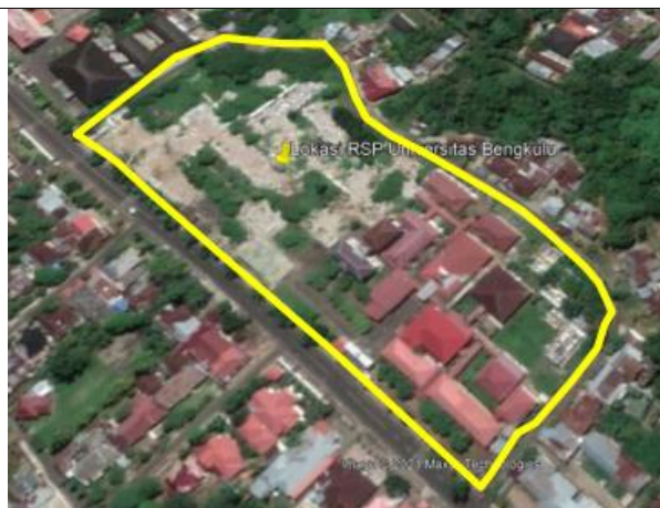
Gambar 4. Kondisi tapak rencana pembangunan RS UNIB
