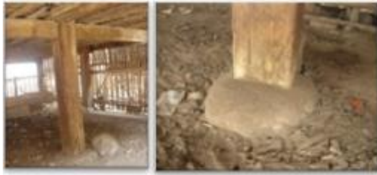
Gambar 4: Bentuk Pondasi Rumah Tradisional Panjalin
