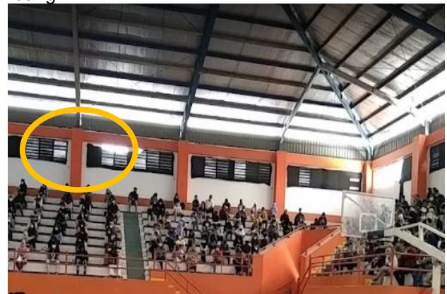
Gambar 3. Bukaan Lebar yang Difungsikan Sebagai Sirkulasi Udara, Sunscreen Dan Filter Debu. Sumber: Dokumentasi Pribadi
