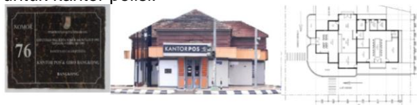
Gambar 3. Bangunan kantor pos Bangkong Semarang Sumber: survey 2020
