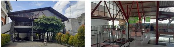
Gambar 2. Kondisi Eksisting Kantin Kampus 3
