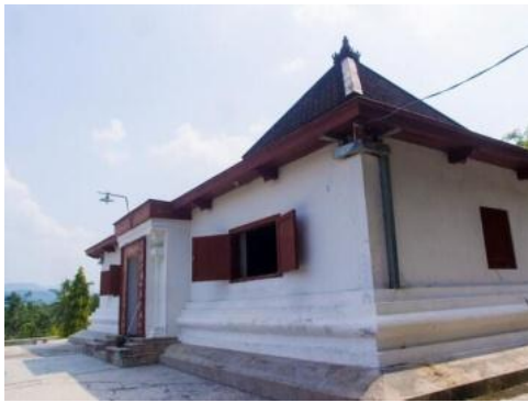
Gambar 29. Bentuk Atap Bangunan Masjid Sunan Pandanaran
