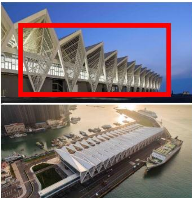
Gambar 13. Irama selubung bangunan TPKL Qingdao
