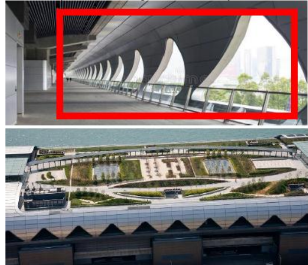
Gambar 14. Irama selubung bangunan TPKL Kaitak Sumber: Sumber: www.Archdaily.com
