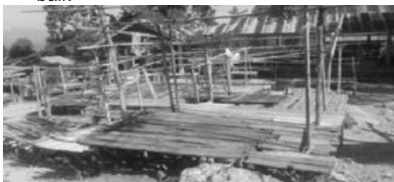
Gambar 6. kondisi pasar yang tidak nyaman Sumber: Dokumentasi Penulis. 2020
