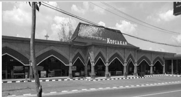
Gambar 19. Tidak ada tribut legibitas pada bangunan Sumber: survey 2020
