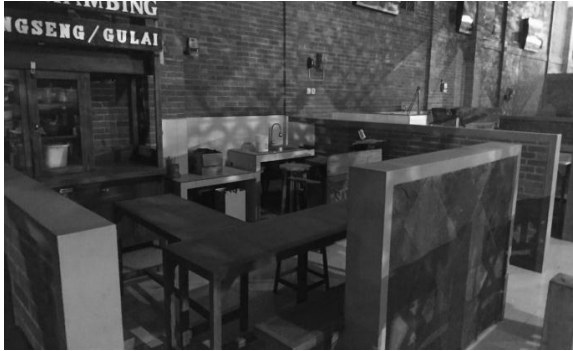
Gambar7. Suasana setelah renovasi Sumber: survey 2020
