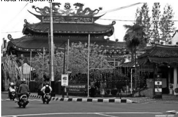
Gambar 6. Bangunan Klenteng Liong Hok Bio
