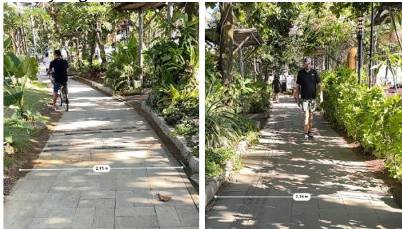
Gambar 3. Kondisi Jalur Segmen 2 Sumber : Dokumentasi Penulis, 2025
