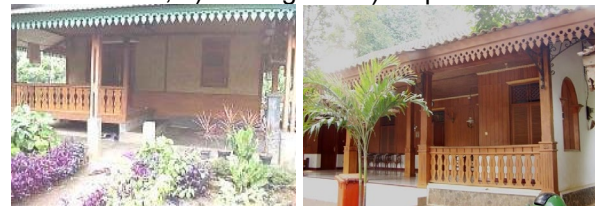
Gambar 4. Tampak struktur konstruksi (1) Rumah Betawi panggung rendah (2) Rumah Betawi tanpa kolong (sumber: https://www.kebudayaanbetawi.com )
