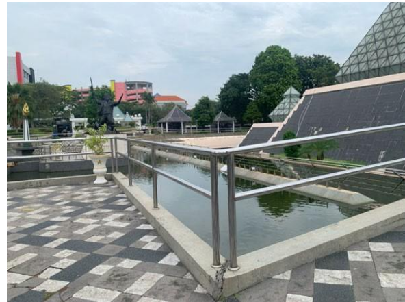
Gambar 6. Handrail Pada Tepi Kolam
