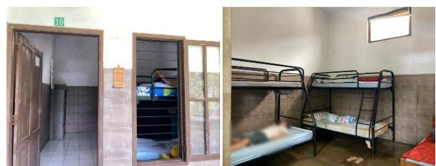
Gambar 15. Dokumentasi Perletakkan Jendela Pada Ruang (Sumber : Penulis, 2025)
