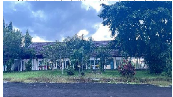
Gambar 5 . Tampak Belakang (Sumber: Dokumentasi Pribadi Penulis, 2025)
