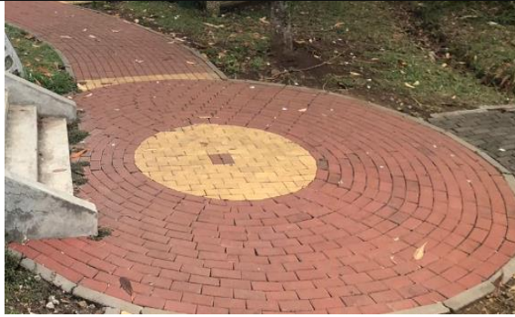
Gambar 13. Penggunaan paving block pada jalur pedestrian
