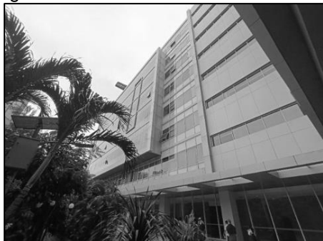
Gambar 5. Gedung Direktorat Jenderal Sumber Daya Air
