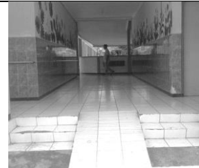
Gambar 21 Ramp Koridor Kelas Tanpa Rubber Ramp , Handrail , dan Curam Sumber: Analisa Pribadi, 2024
