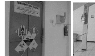
Gambar 29 Rambu Resiko Kebakaran
