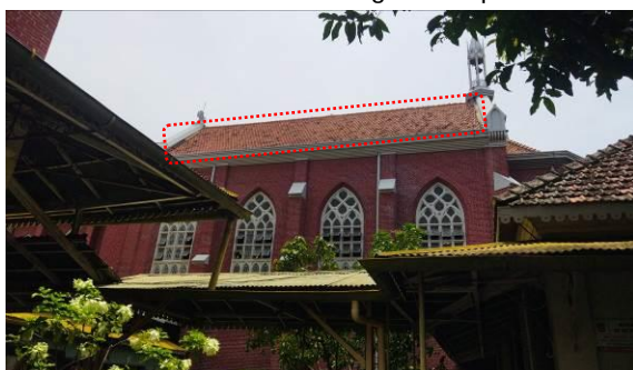
Gambar 4. Tampak depan bangunan kapel dari Jalan Ronggowarsito
