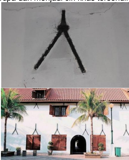
Gambar 6. Angkur berbentuk “Y” Terbalik di Gedung Galangan Kapal (atas) dan Museum Bahari (bawah)
