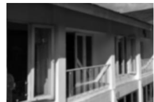
Balkon Pada Bangunan Lama
