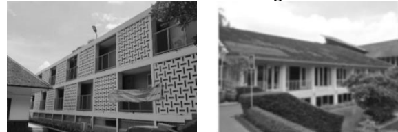
Atap Pada Bangunan Baru
