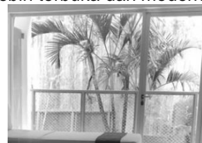
Balkon Pada Bangunan Baru
