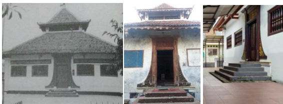
Gambar 3. Keberadaan tangga yang selalu menempel sebagai bagian fasad masjid Angke
