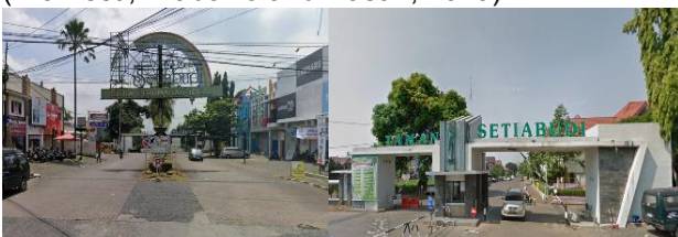
Gambar 3. Boulevard dan Pintu Masuk Perumahan Taman Setiabudi. Sumber: Google Map, 2024
