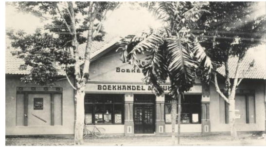
Toko buku Boekhandel & Drukkerij Van Keulen di Soceiteit Straat ini memperlihatkan penggunaan atap pelana tropis sederhana seperti di kampung-kampung. (Sumber : https://naratasgaroet.wordpress.com/2015/09/08/ )
