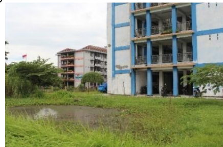
Gambar 11. Kondisi Kolam Ikan di Depan Rusun
