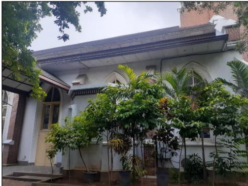
Gambar 9. Finishing Dinding Acian yang Dicat Dinding Warna Putih Gereja Katolik Santo Yusuf Gedangan (dokumentasi pribadi)
