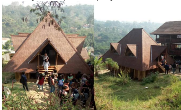
Gambar 1. Bangunan Gedung Serba Guna Sekolah Alam Bandung, berlokasi di Bandung Utara
