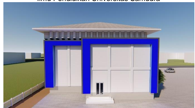
Gambar 3. Tampak Belakang Bangunan Fakultas Keguruan Ilmu Pendidikan Universitas Samudra
