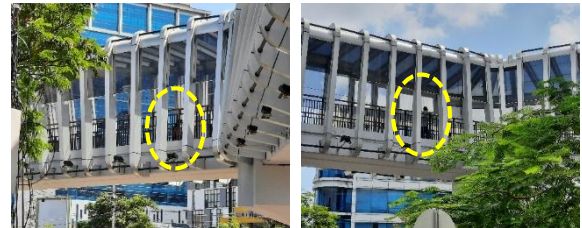
Gambar 9. Pengguna yang melewati skybridge
