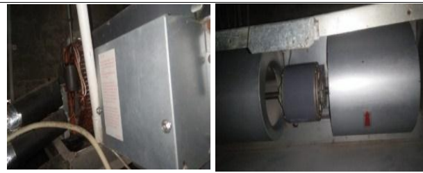
Gambar 10. Salah Satu Unit AC Indoor FCU (Sumber : Penulis,2021)
