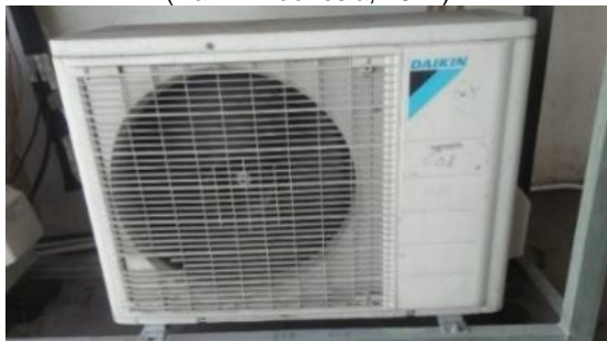
Gambar 8. Salah Satu Unit AC Outdoor (CU) Kapasitas 1,5 PK
