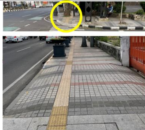
Gambar 4. Ramp Pada Jalur Pedestrian
