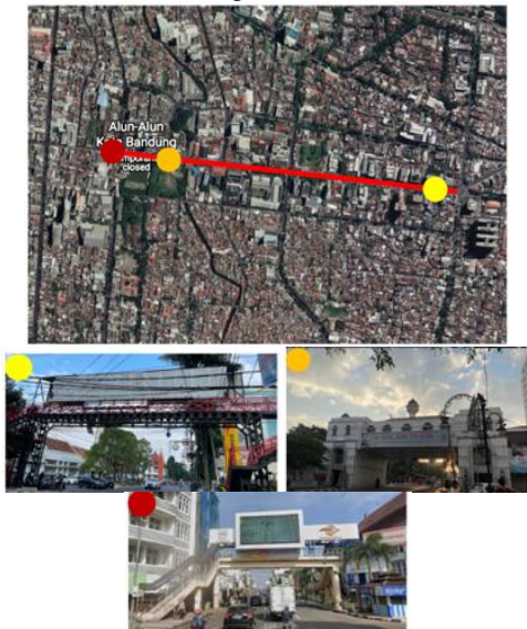
Gambar 7. Jembatan Penyebrangan Orang Kelompok Pelayanan Transportasi
